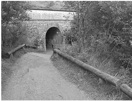
Sti ved viadukt under banelinien nord for Teknisk Skole Foto: Poul Højbak
